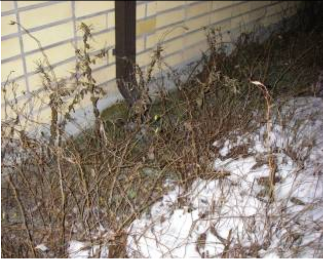
Kuva 1. Perustusten kosteusrasitusta lisää puutteet maanpinnan muotoilussa, epäkuntoiset betoniset sadevesikourut sekä kasvillisuus seinän vierustalla.
